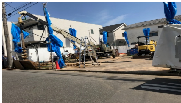
地下のための土留め H 鋼埋設開始 2020 5/15
