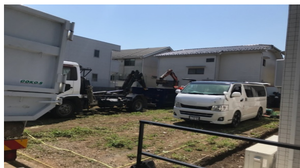
ブロック塀壊し・井戸掘準備 2020 4/25
