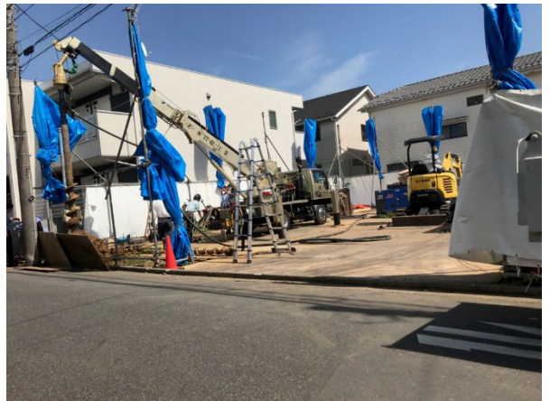
地下のための土留め H 鋼埋設 2020 5/15
