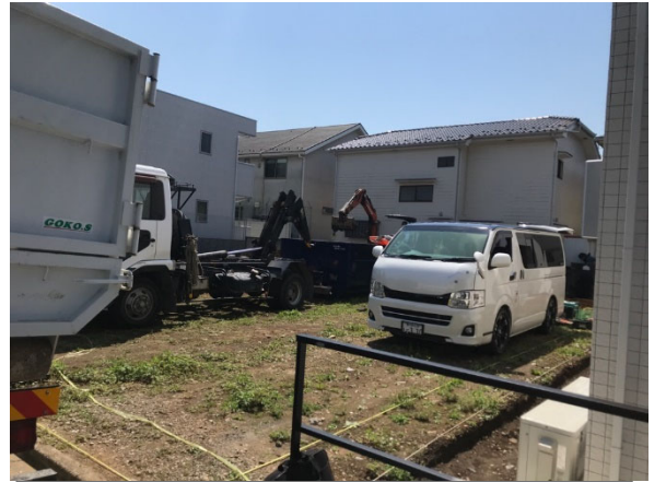
ブロック塀壊し・井戸掘準備 2020 4/25
